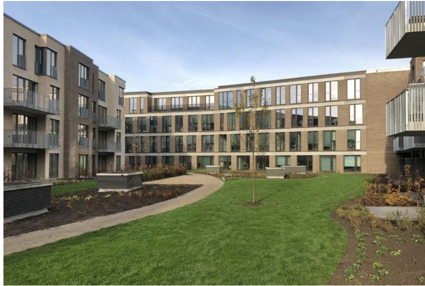
Blick auf den fertiggestellten Wohnhof 2
